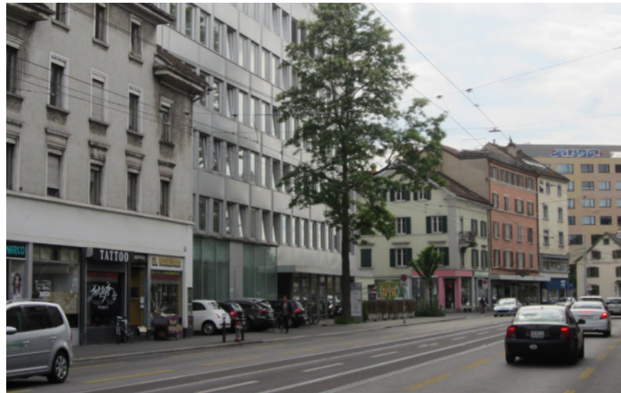
Beispiele Strassenrandbebauung in variierendem Abstand zur Strasse
