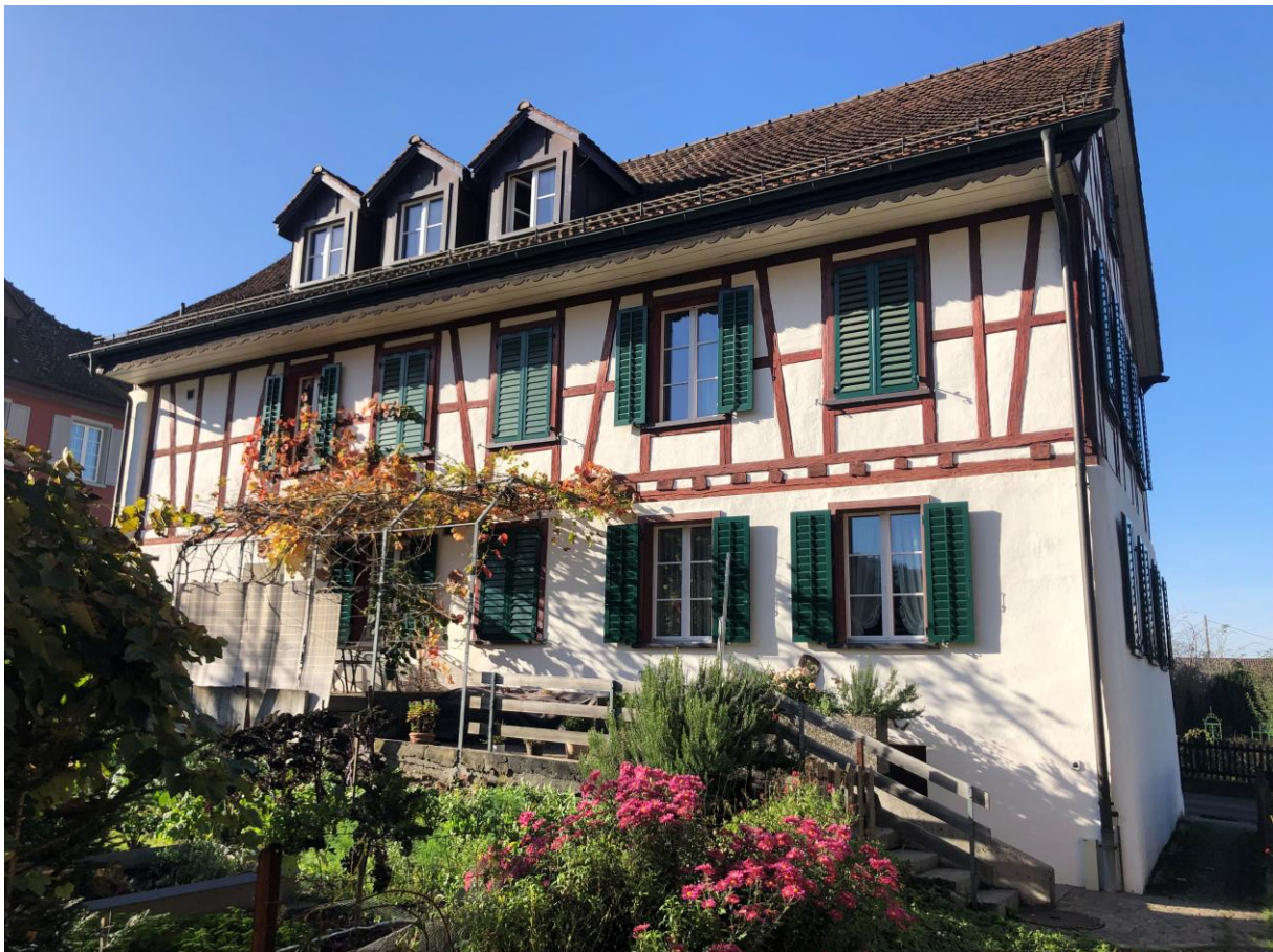
Sanierung Heizung Liegenschaft Dorfstrasse 15, Neuenhof
