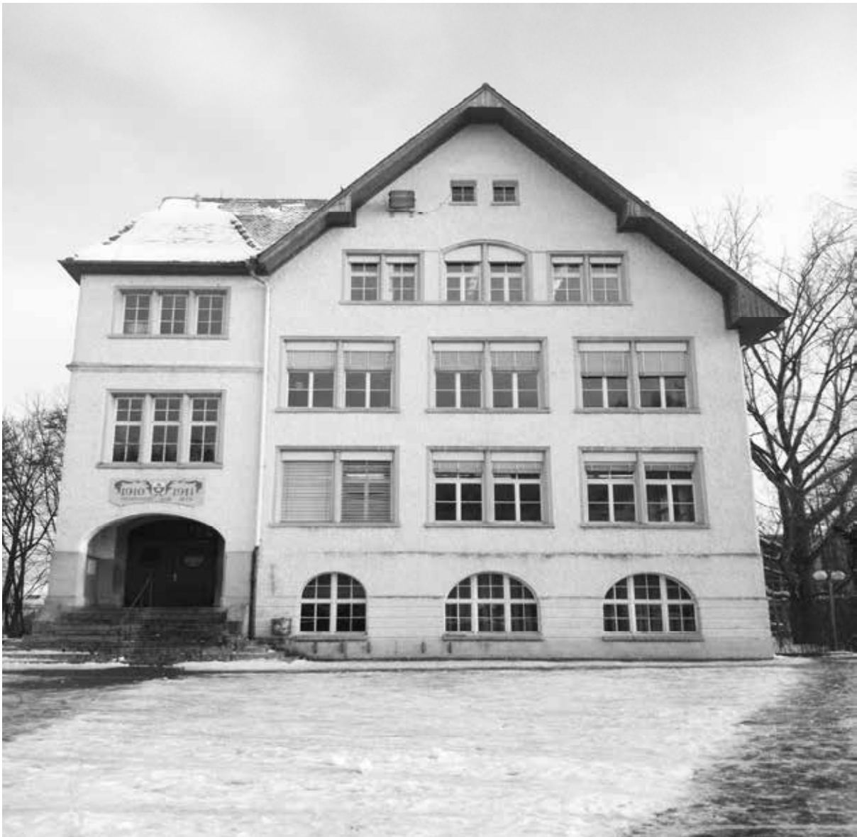
Hauptfassade Süd Altes Schulhaus
