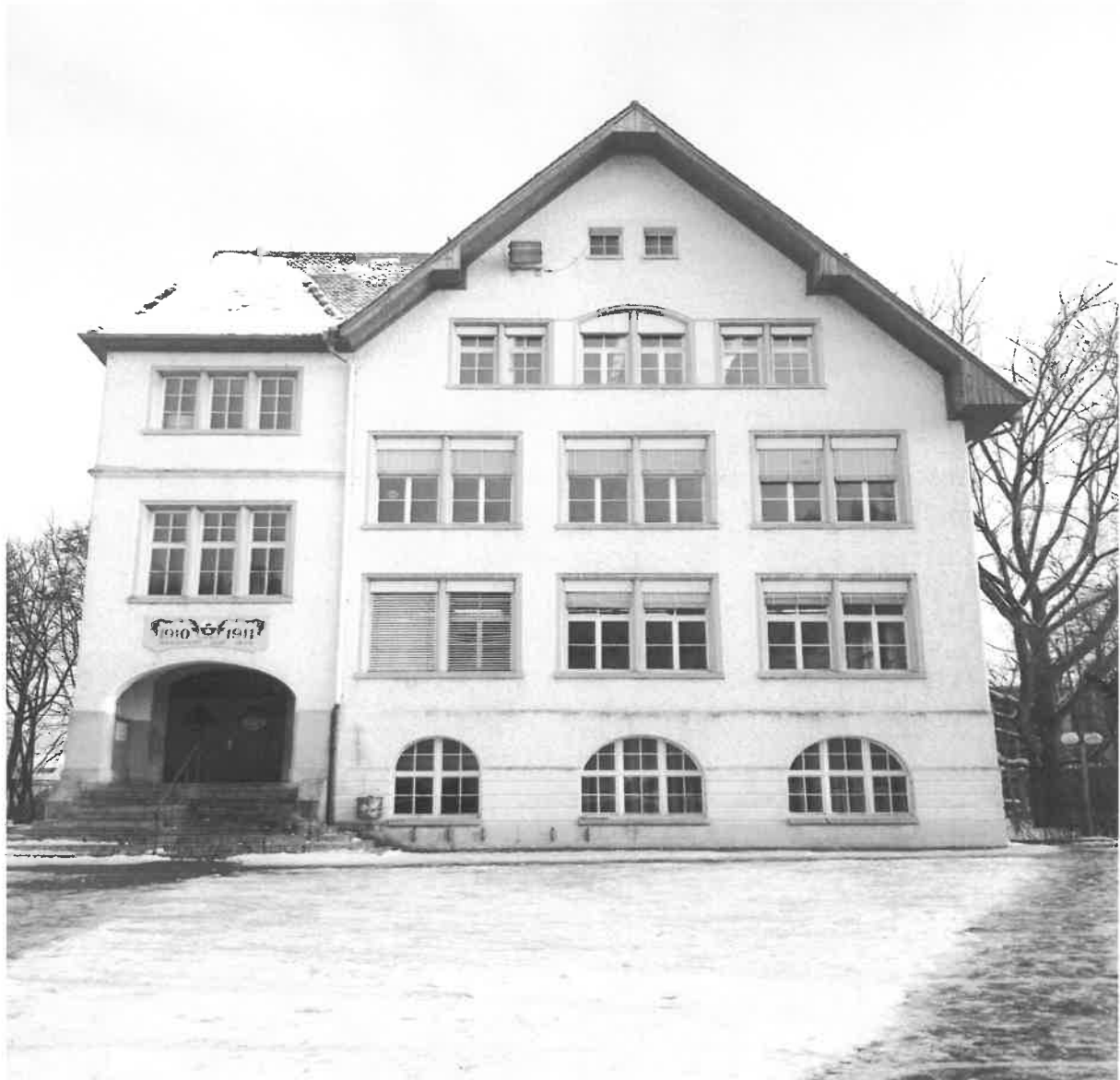
Hauptfassade Süd Altes Schulhaus
